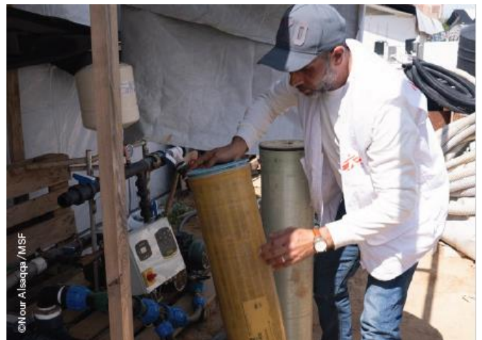
写真は逆浸透装置で水の脱塩と浄化に使用される膜
