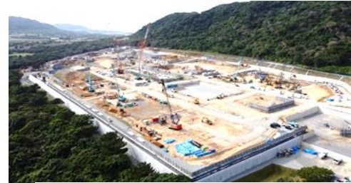
建設中の基地(500~600名配置)
