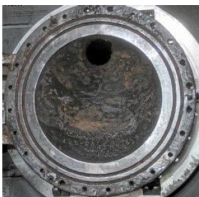
堆積（たいせき）物を除去する前の貫通口。ほぼ全体が覆われていた＝国際廃炉研究開発機構提供
